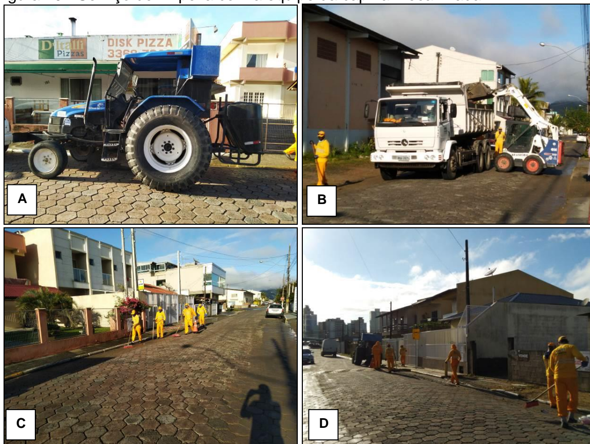
Figura 70 - Serviço de limpeza com a equipe da capina mecanizada.
