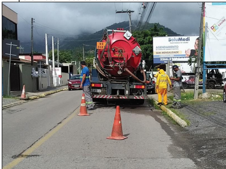
Figura 75 - Limpeza mecanizada de boca de lobo.
