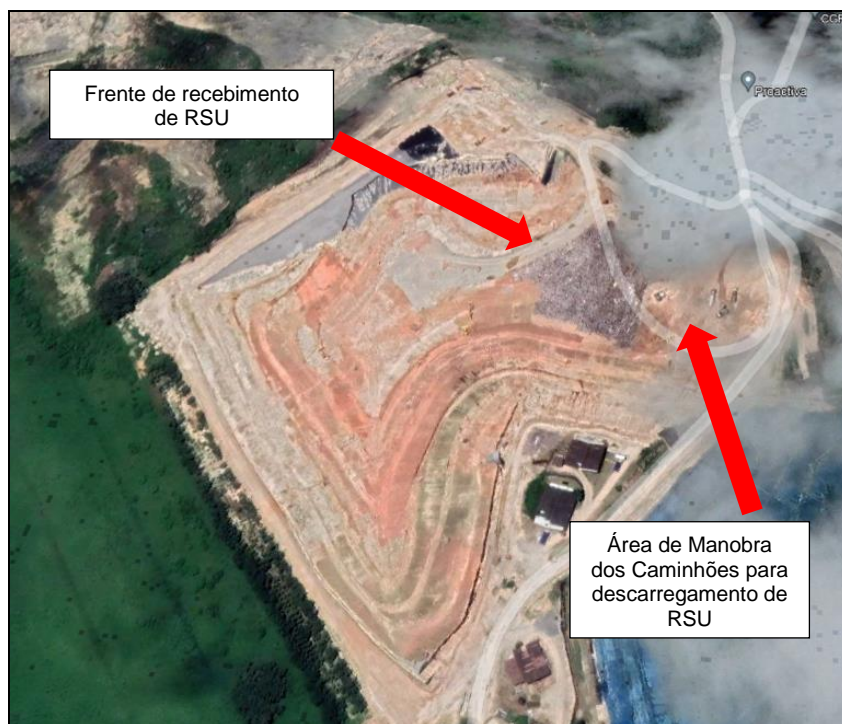
Figura 37 - Frente de recebimento e disposição de RSU nas células do aterro sanitário.
