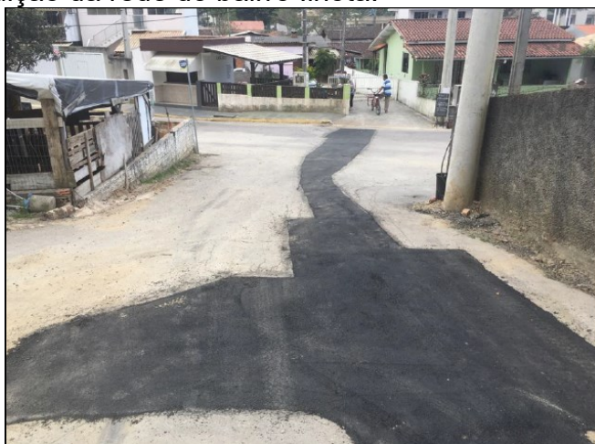
Figura 86 - Substituição da rede do bairro Ilhota.
