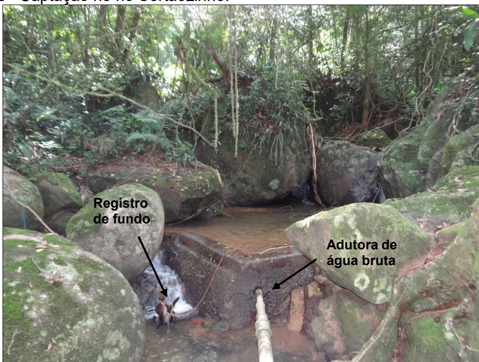
Figura 52 - Captação no rio Sertãozinho.
