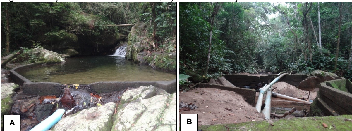
Figura 43 - A) Barramento a montante; B) Barramento a jusante.
