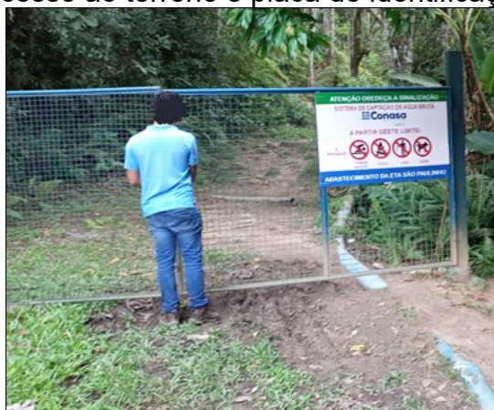
Figura 45 - Portão de acesso ao terreno e placa de identificação da área.
