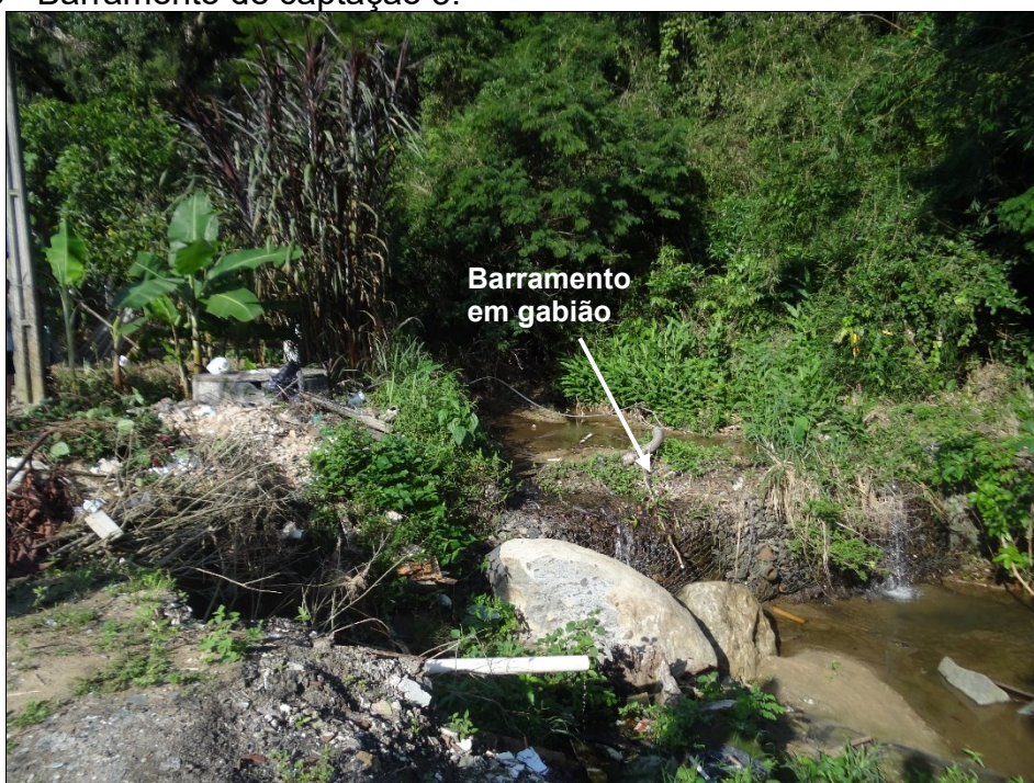
Figura 59 - Barramento de captação 3.
