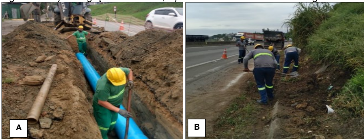
Figura 85 - A) Interligação da adutora; B) Assentamento da adutora de água tratada.
