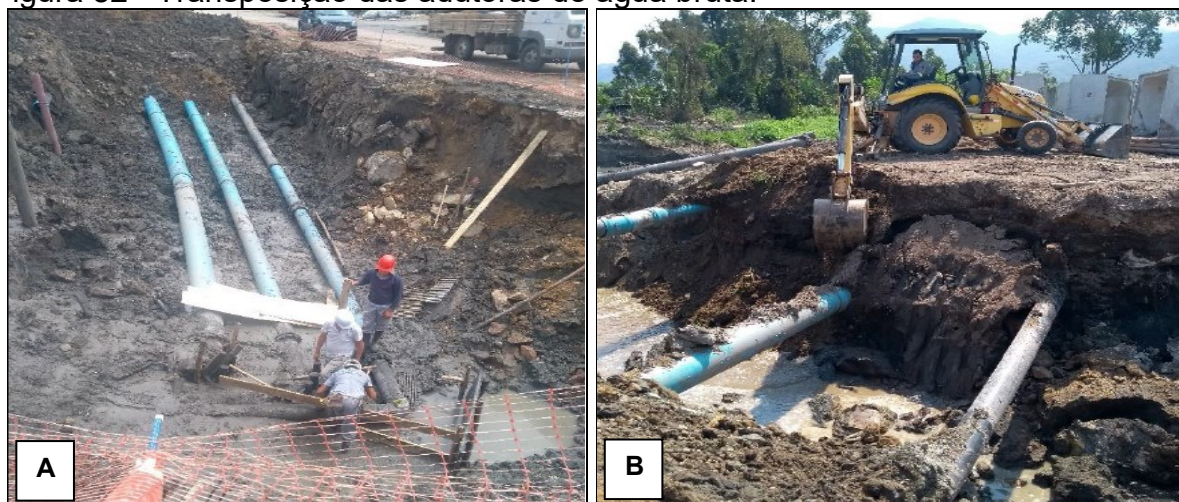
Figura 82 - Transposição das adutoras de água bruta.
