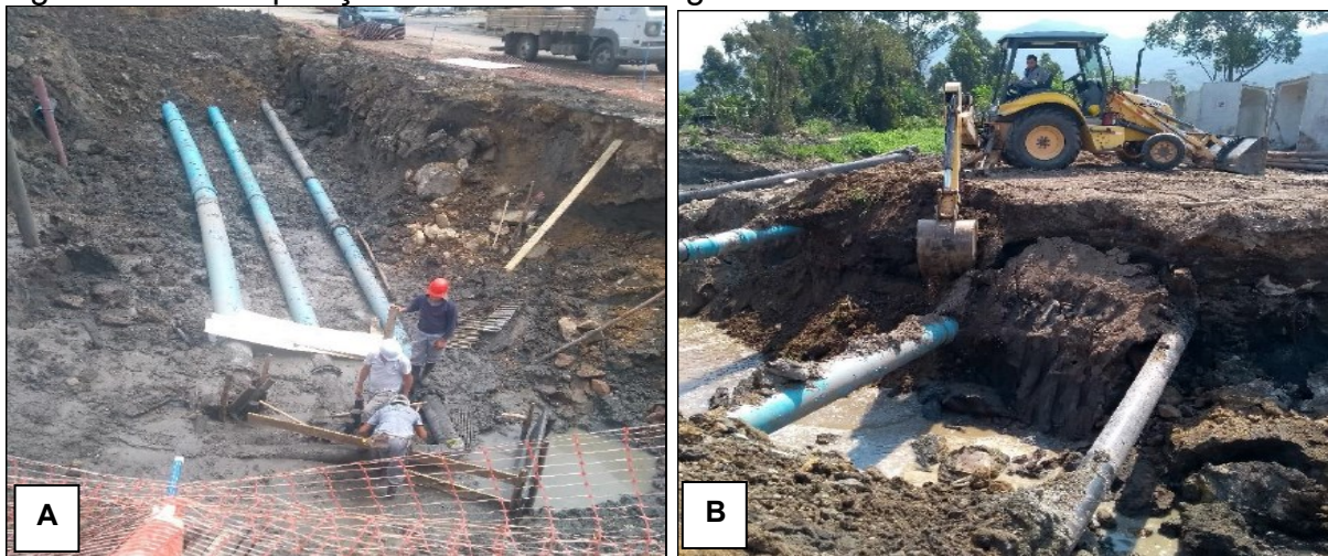
Figura 16 - Transposição das adutoras de água bruta.
