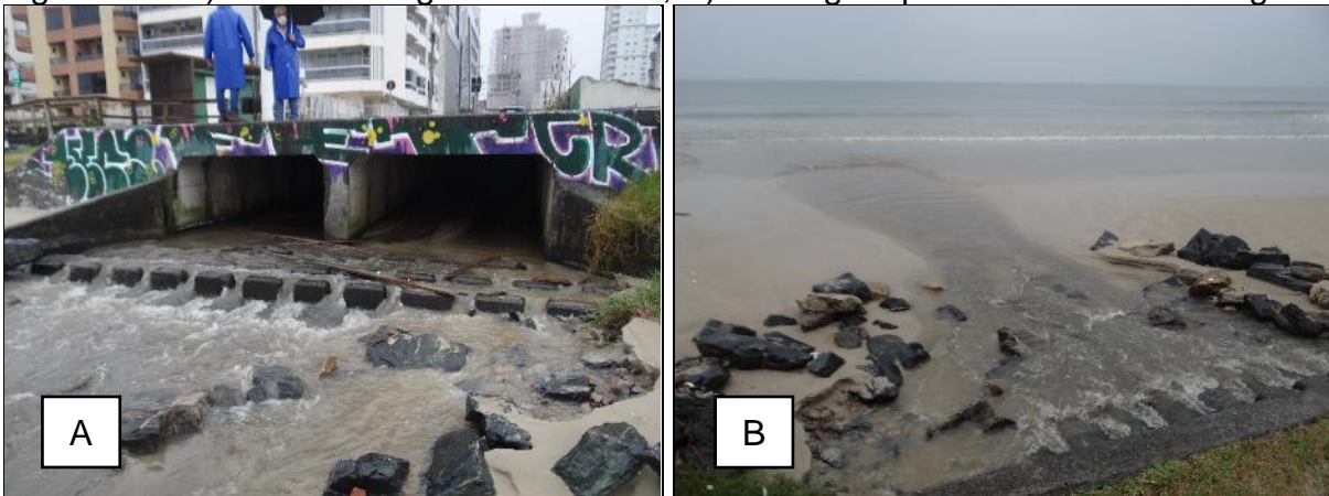
Figura 28 - A) Macrodrenagem da rua 205; B) Drenagem pluvial da macrodrenagem.
