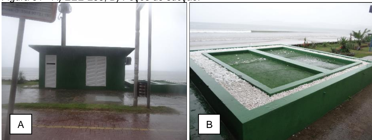
Figura 51 - A) EEE-255; B) Poços de sucção.
