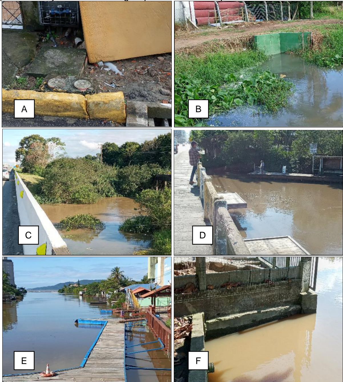
Figura 30 - A) Ligação domiciliar de esgoto, bairro Morretes; B) ponto de saída de esgoto tratado ETE Morretes, rio da Fita; C) ponte BR 101, rio Perequê; D) ponte rio Perequê, Av. Nereu Ramos; E) marina próximo à embocadura do rio Perequê; F) ponto de lançamento de drenagem pluvial no rio Perequê.
