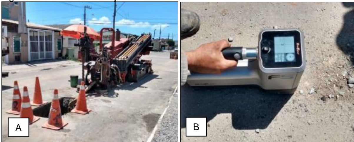
Figura 83 - Método de furação não destrutiva.
