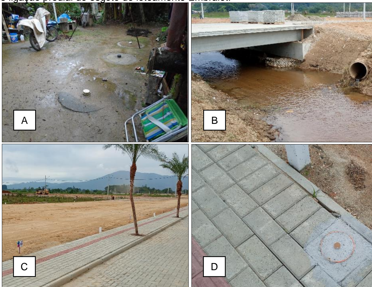
Figura 27 - A) sistema fossa sumidouro - SAC Marlete; B) Ponte com drenagem pluvial sobre rio Perequê que corta o Loteamento Embralot; C) e D) Detalhe de pavimentação e ligação predial de esgoto do loteamento Embralot.
