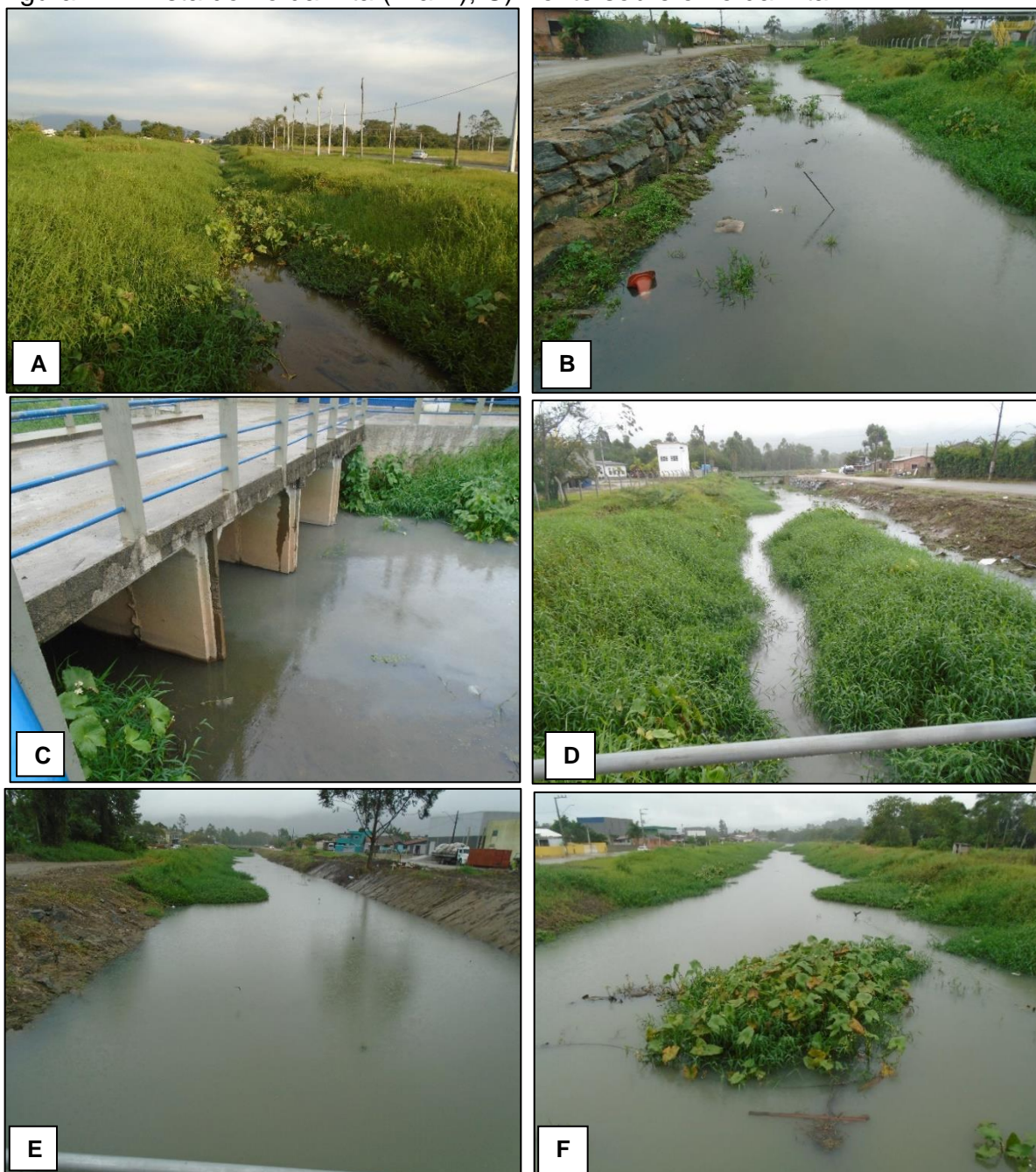
Figura 74 - Vista do rio da Fita (A a E); C) Ponte sobre o rio da Fita.
