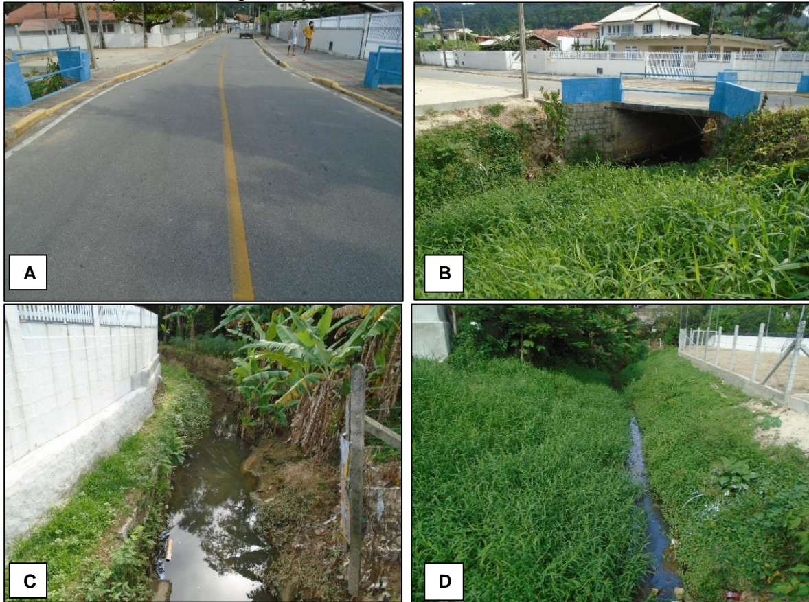
Figura 13 - A) Ponte de transição de via; B) Estrutura da ponte; C) Microdrenagem a montante; D) Microdrenagem a jusante.
