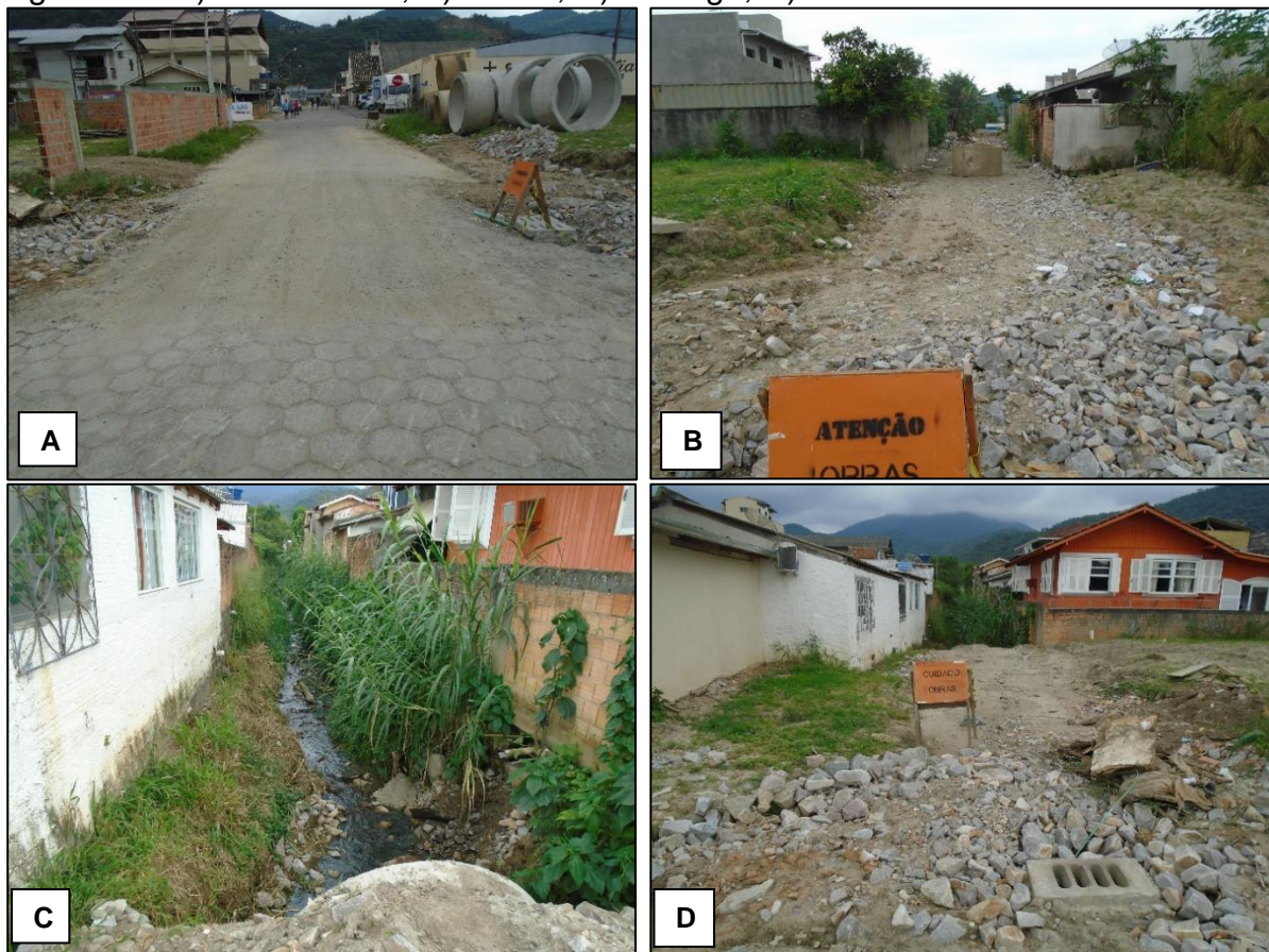
Figura 49 - A) Geral da via; B) Obras; C) Córrego; D) Obras.
