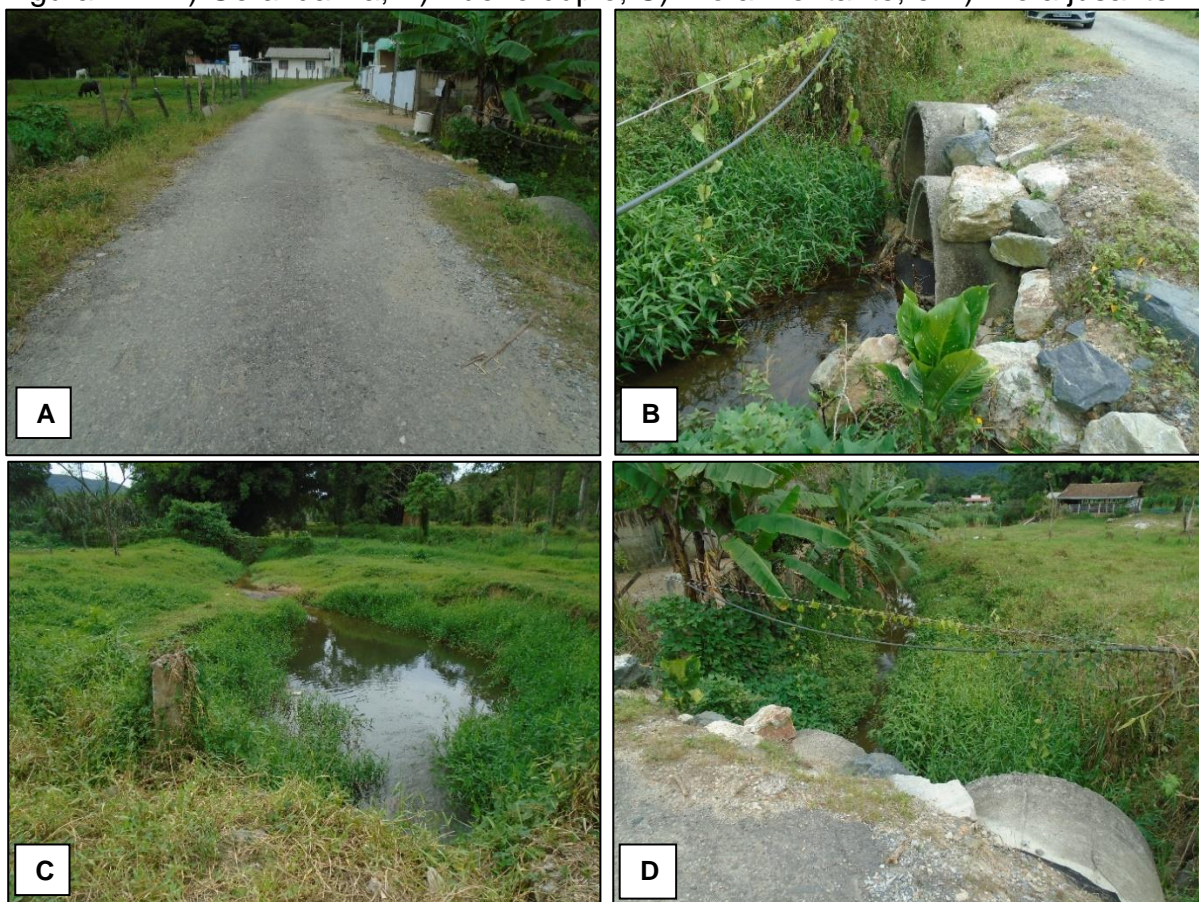
Figura 21 - A) Geral da via; B) Bueiro duplo; C) Rio a montante; e D) Rio a jusante.
