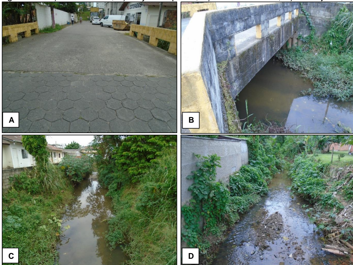
Figura 26 - A) Geral da via; B) Seção da ponte; C) Rio a montante; D) Rio a jusante.
