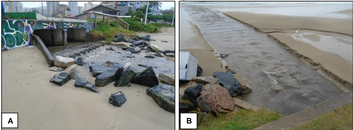
Figura 67 - A e B) Lançamento macrodrenagem.
