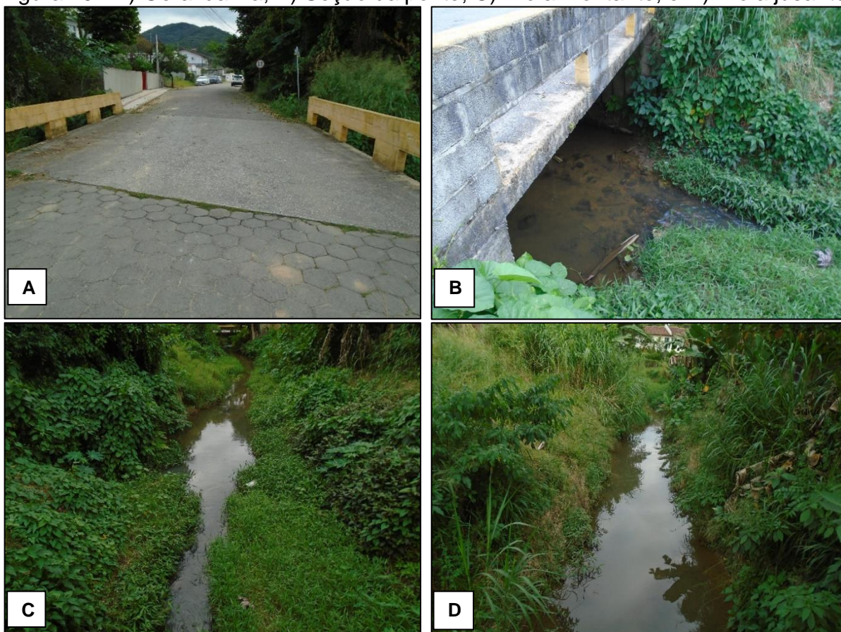
Figura 29 - A) Geral da via; B) Seção da ponte; C) Rio a montante; e D) Rio a jusante.
