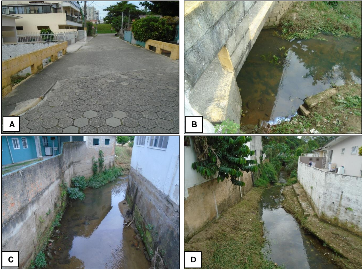
Figura 28 - A) Geral da via; B) Seção da ponte; C) Rio a montante; e D) Rio a jusante.
