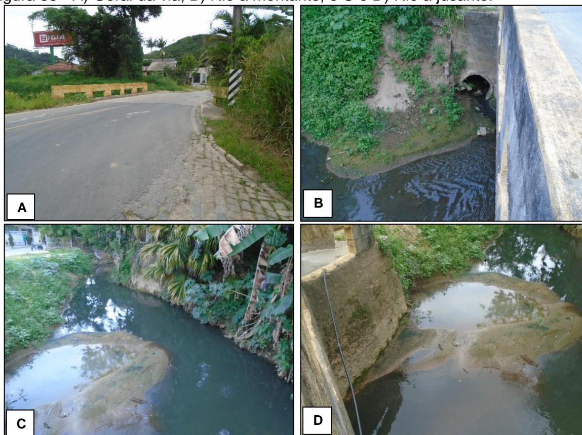
Figura 55 - A) Geral da via; B) Rio a montante; e C e D) Rio a jusante.
