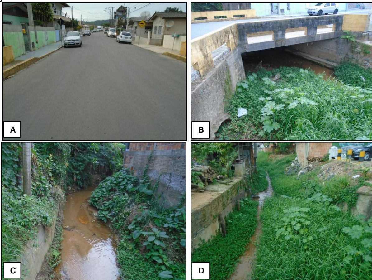
Figura 44 - A) Geral da via; B) Seção da ponte; C) Córrego a montante; D) Córrego a jusante.
