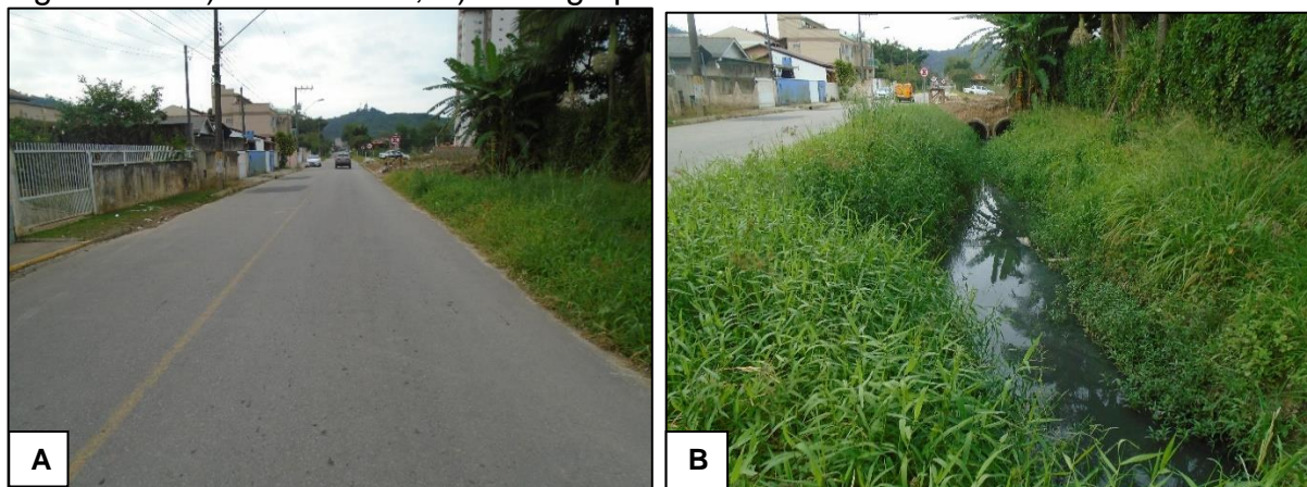
Figura 42 - A) Geral da via; B) Córrego paralelo a via.
