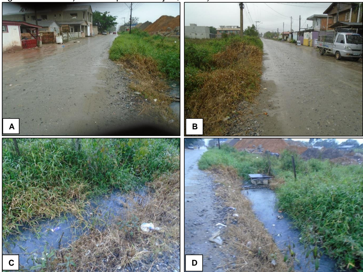
Figura 69 - A e B) Via sem pavimentação; C e D) Vala a céu aberto.
