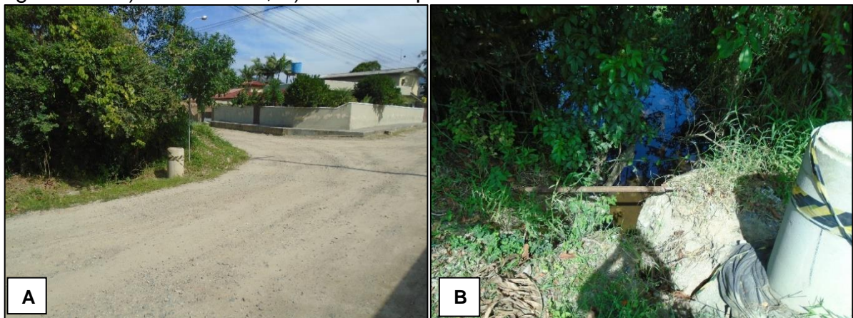
Figura 54 - A) Geral da via; B) Bueiro simples tubular de concreto.
