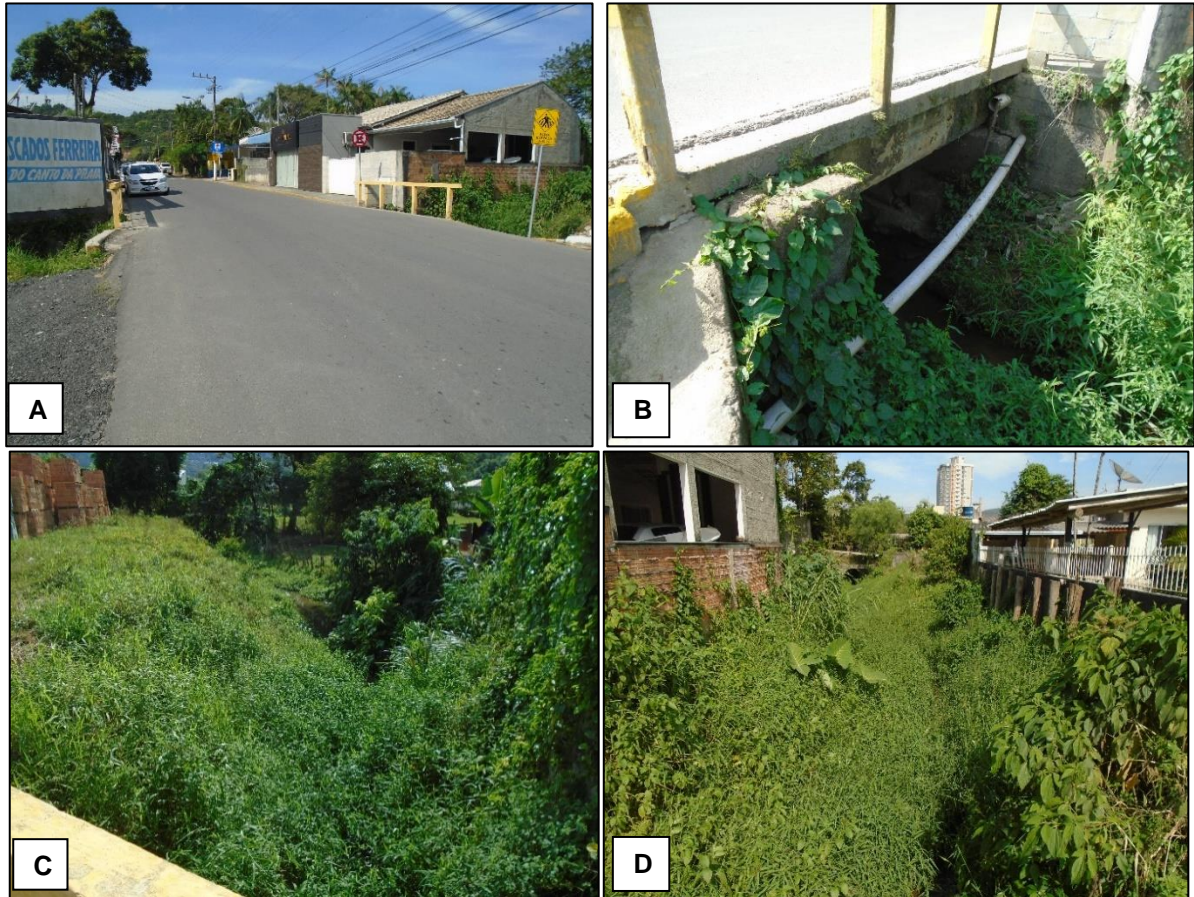
Figura 53 - A) Geral da via; B) Seção da ponte; C) Córrego a montante; D) Córrego a jusante.
