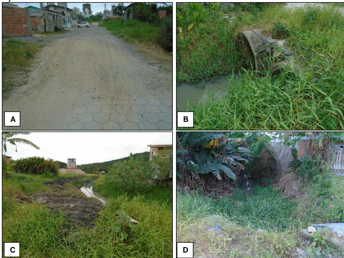
Figura 22 - A) Geral da via; B) Bueiro duplo de concreto; C) Rio a montante; e D) Rio a jusante.
