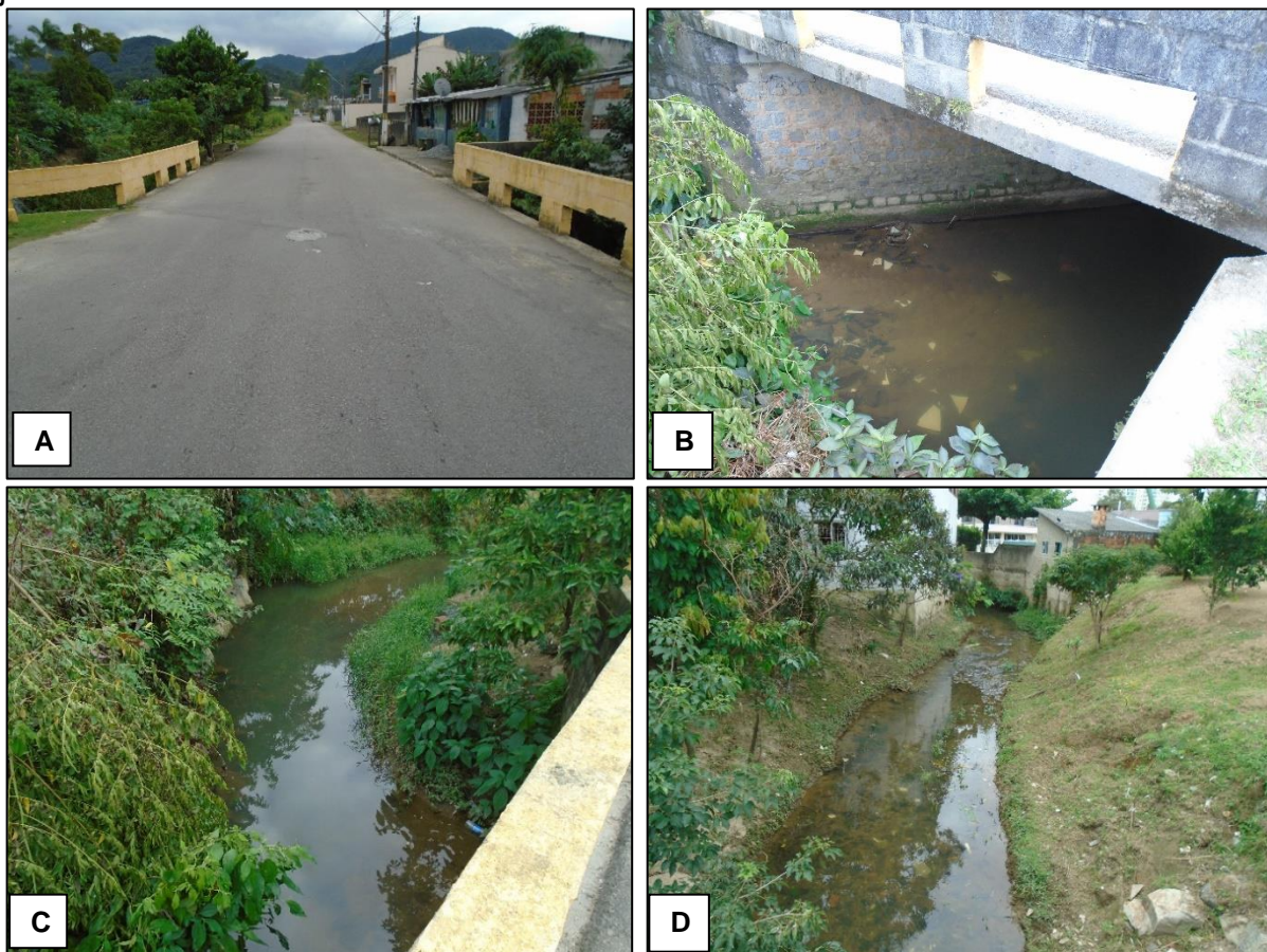
Figura 27 - A) Travessia; B) Estrutura da travessia; C) Rio a montante; D) Rio a jusante.
