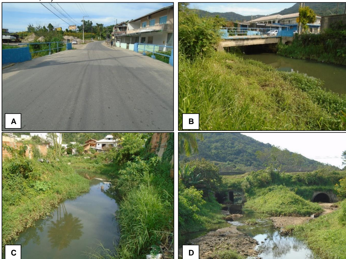
Figura 14 - A) Geral da via; B) Ponte sobre o rio Mata Camboriú; C) Rio Mata Camboriú; D) Galerias e tunnel liner sob a BR-101.
