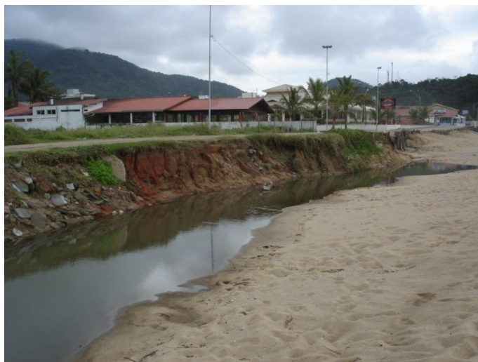
Figura 1.8 - Aterro para construção de edificações na orla da praia Fonte: NEAmb UFSC, 2009
