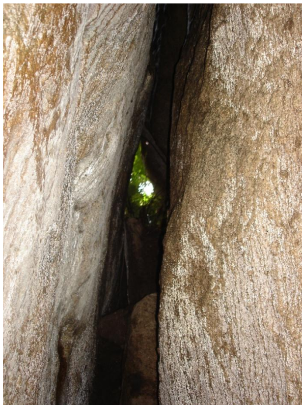
Figura 1.51 - Passagem reduzida pela queda de blocos Fonte: NEAmb UFSC, 2009
