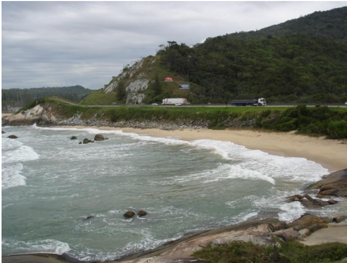
Figura 1.10. Aterro para construção da rodovia federal BR-101 Fonte: NEAmb UFSC, 2009
