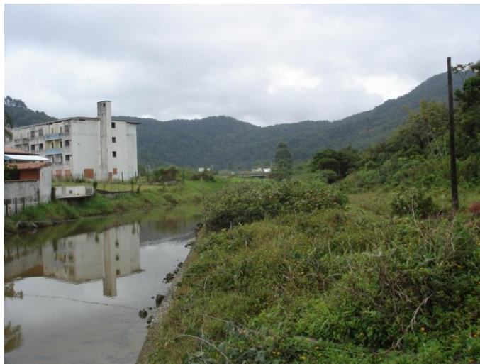
Figura 1.7 - Área de antigo mangue, atualmente aterrada para construção de edifício, ocasionando assoreamento do rio.
