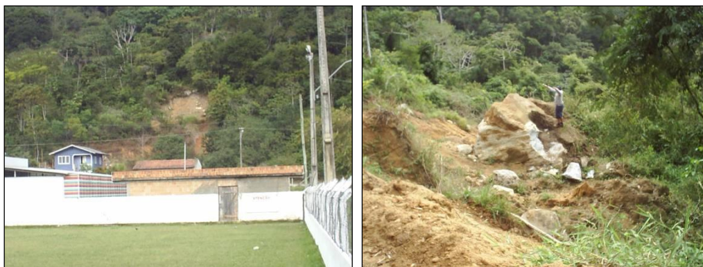
Figura 1.10 (A e B) - A: Cicatriz de deslizamento na base da encosta próximo a casas; B: Parte do material do deslizamento removido na estrada Campo do Areal, ocasionado pelas chuvas de novembro de 2008
