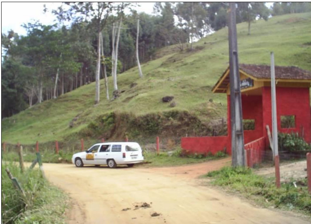
Figura 1.2 - Depósito colúvio-aluvional junto à encosta
