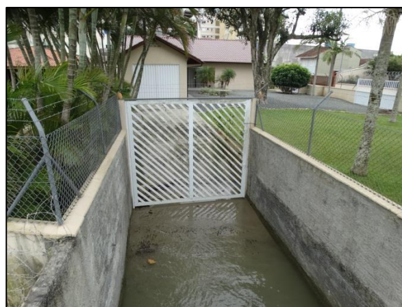
Figura 53: Rampa de acesso náutico de uma residência situada na margem do Rio Perequê, no município de Itapema.
