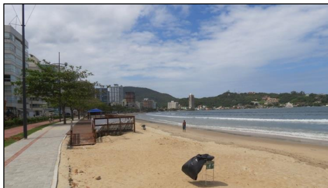
Figura 115: Tomada da orla do município de Itapema onde é possível observar as contenções implantadas tendo em vista a melhor preservação do Parque Linear.
