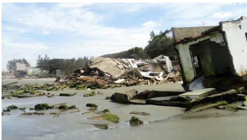
Figura 117: Erosão costeira na região da Ilha Comprida (SP). Fotos: Paulo Henrique Gomes de Oliveira Sousa.
