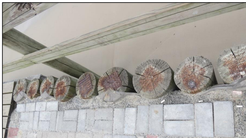
Figura 116: Contenção implantada na orla do município de Itapema, formada por conjunto de toletes de eucalipto autoclavado e manta geotêxtil. Medida paliativa para minimizar os impactos ocasionados pela erosão costeira nas infraestruturas existentes.
