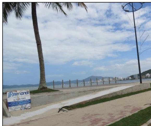
Figura 103: Orla central do município de Itapema. Fonte: OAP Consultores Associados.
