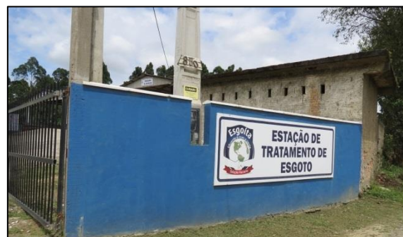
Figura 51: Estação de Tratamento de Esgoto (ETE).
