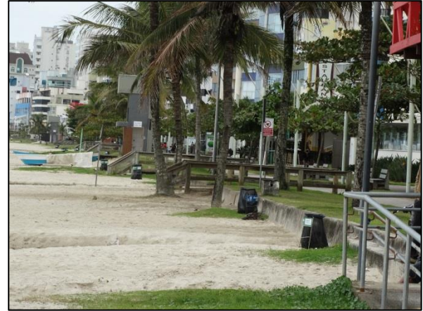
Figura 105: Equipamentos públicos na orla do município.
