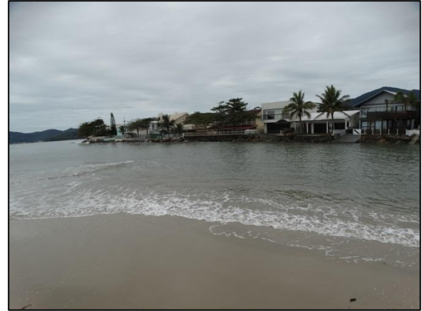
Figura 55: Residências construídas na margem do Rio Perequê, no município de Porto Belo, próximo à desembocadura do rio no mar.
