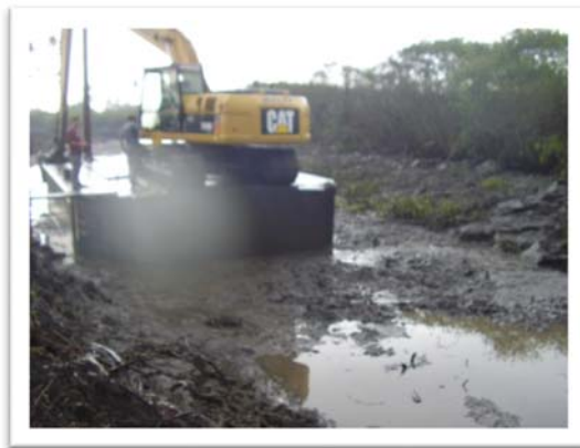
Figura 9 – Exemplo de movimentação de escavadeira hidráulica sobre flutuante
