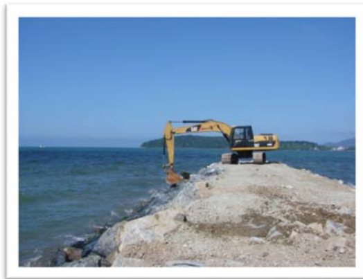
Figura 8 – Exemplo de execução de obra sobre enrocamento existente com escavadeira hidráulica
